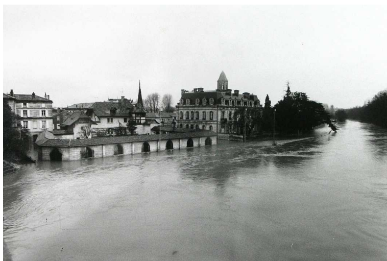
Illustration 8 : Inondation de 1982 à Angoulême quai de la Charente [© J-P. GUILLAUME – Archives Ville d'Angoulême]
